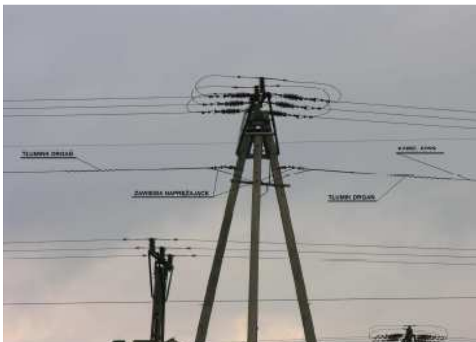
rys. 12. Kabel ADSS z zawieszami naprężającymi
